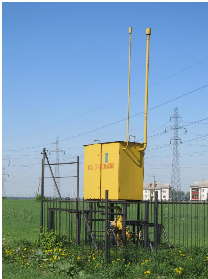
Рисунок 13. Шкафной газорегуляторный пункт.
